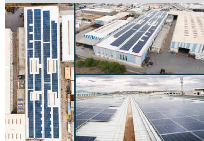
Installation de 600 kWc en régime d'autoconsommation à Z.I de Radès (réalisée en 2024)
